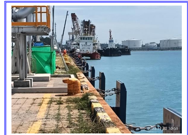
รูปที่ 3-10 Fender ป้องกันเรือกระแทกท่า
