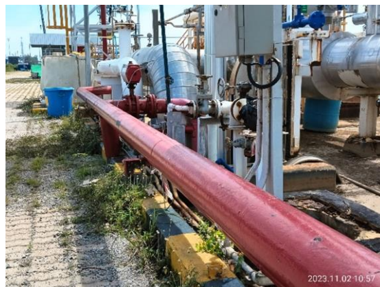
รูปที่ 3-3 Curb ป้องกันการรั่วไหลของสารเคมี
