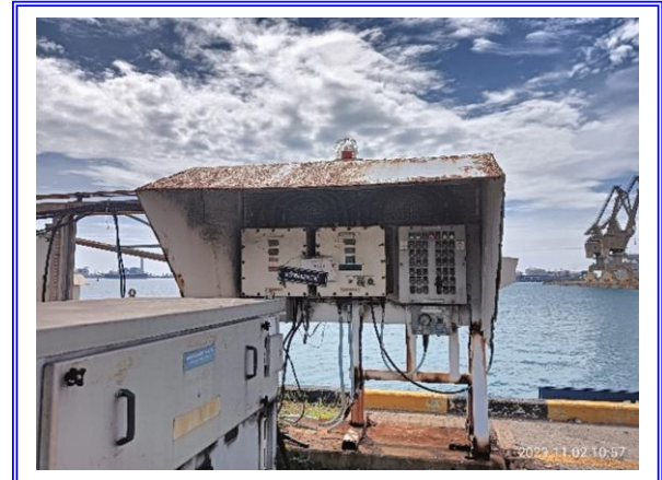
รูปที่ 3-33 แผงควบคุมการขนถ่ายแบบ Manual System
