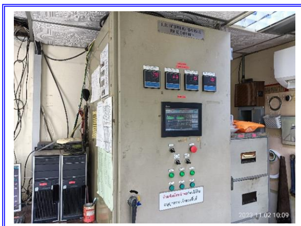
รูปที่ 3-31 ระบบ DCS ที่ Control Room ควบคุมการสูบน้ำบริเวณท่าเรือ
